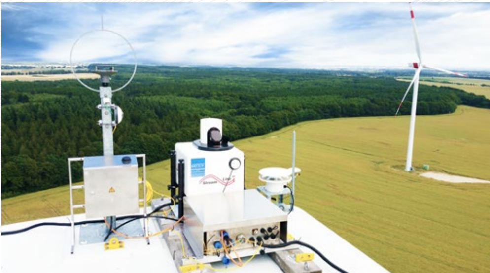
► Messmast am Prototypenstandort Brusow
